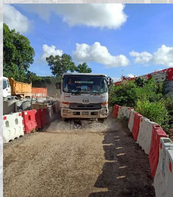
定時以水車灑水防止塵土飛揚
