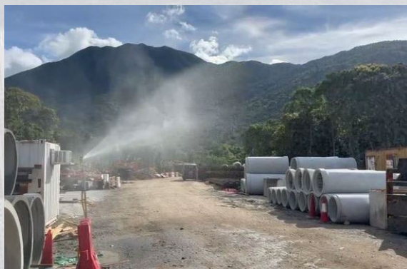
定時於工地進行灑水防止塵土飛揚
