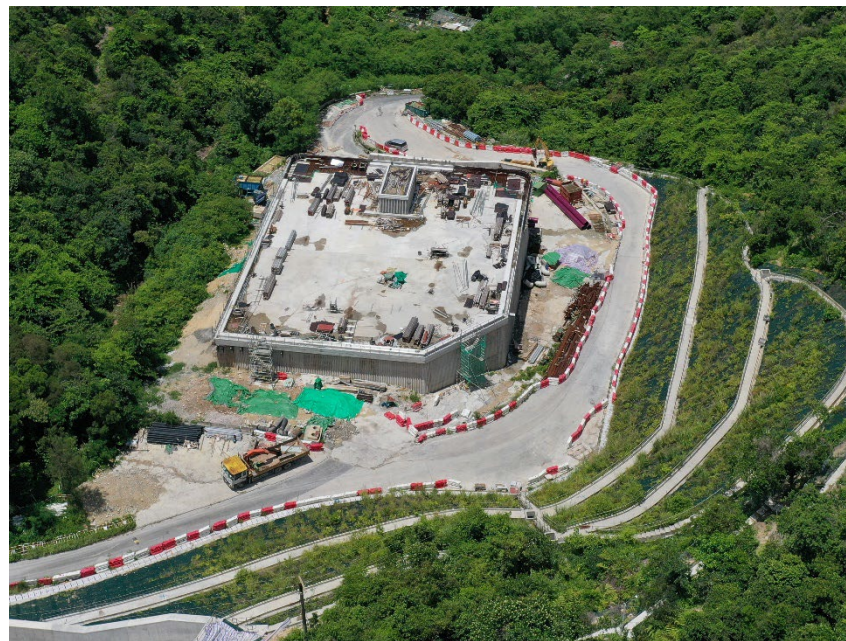
建造海水配水庫
