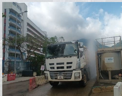
地盤出口設立洗車設施
