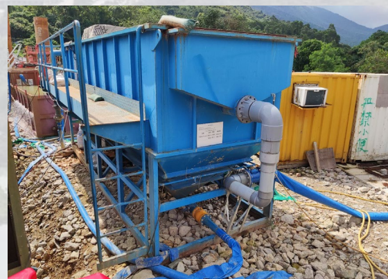
設置污水處理設施
