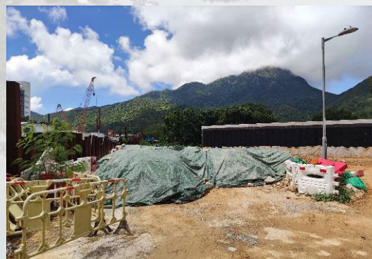
以帆布遮蓋建築物料防止塵土飛揚
