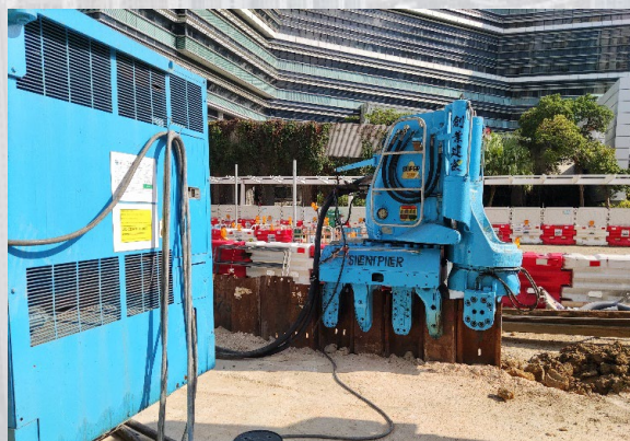
使用靜音機械設備
